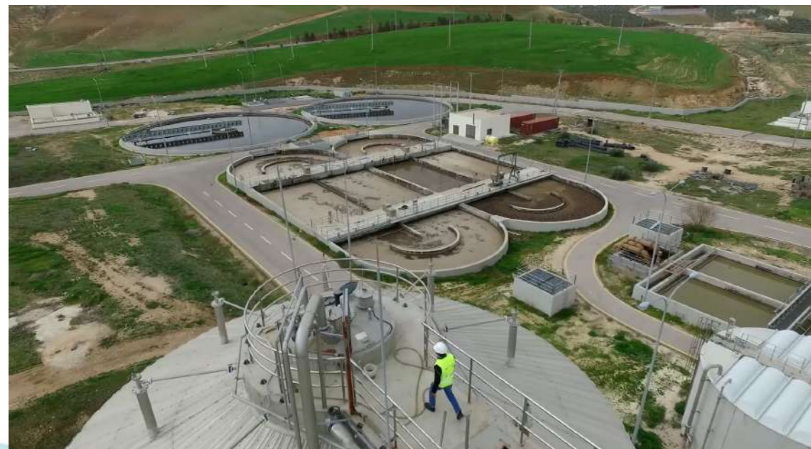
AI - Shallala WWTP-YWC
